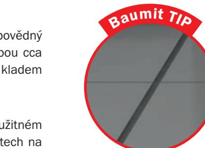
Dilatace provádějte v rastru max. 3x3 m, v max. poměru stran 1:2
