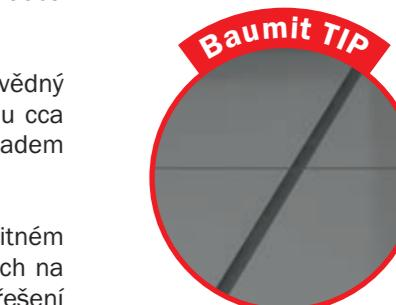
Dilatace provádějte v rastru max. 3x3 m, v max. poměru stran 1:2
