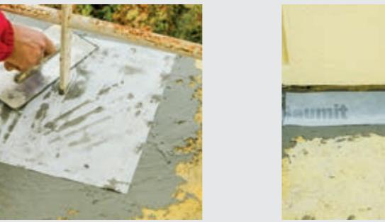
Utěsnění prostupů pomocí hydroizolační bandáže
